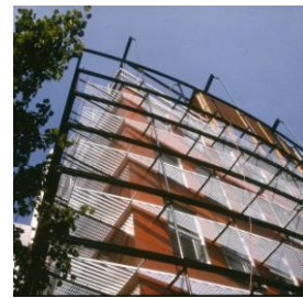
4 Renovatie kantoor Rotterdam
